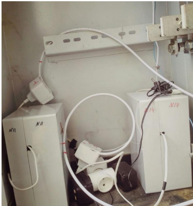
Рис. 2. Установка «Монитор-К» внутри КТП:
